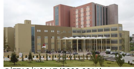
26. DİZTAŞ İNŞAAT (2008-2011) KANUNİ SULTAN SÜLEYMAN 544 YATAKLI HASTANESİ
